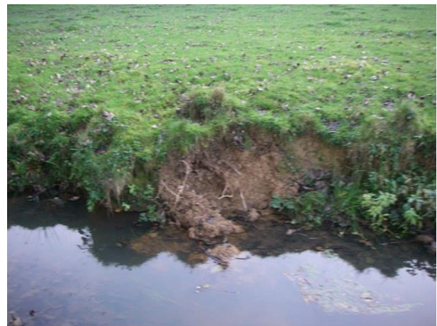
Effondrement de berge. Aucune végétation ne permet son maintien
