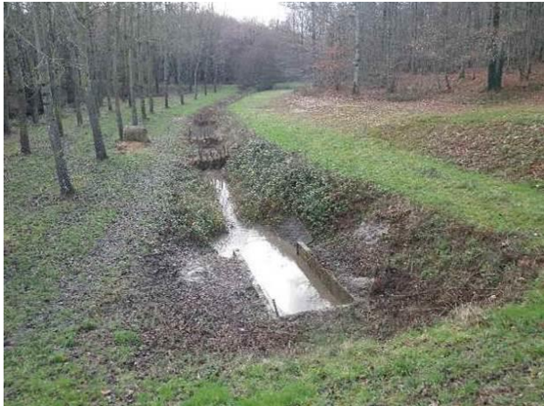
Exemple de mise en place de bottes de paille dans le lit de la rivière le Long (37), à l'aval d'un étang lors de sa vidange
